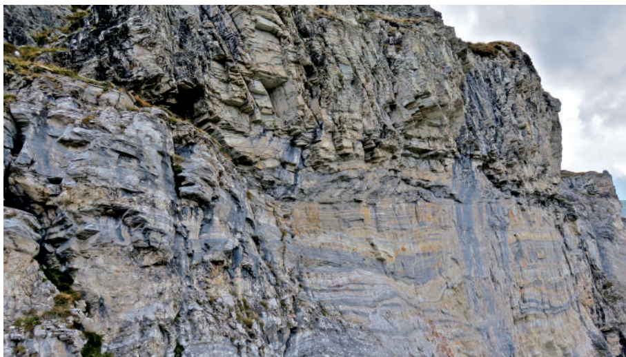
Fig. 3.20 - Parete di Aran. Contatto tettonizzato tra Dolomie stratificate e sovrastanti Quarziti lastroidi con fitta fratturazione trasversale.
